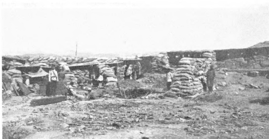
Люнетъ противъ редута № 1. Минныя работы.
