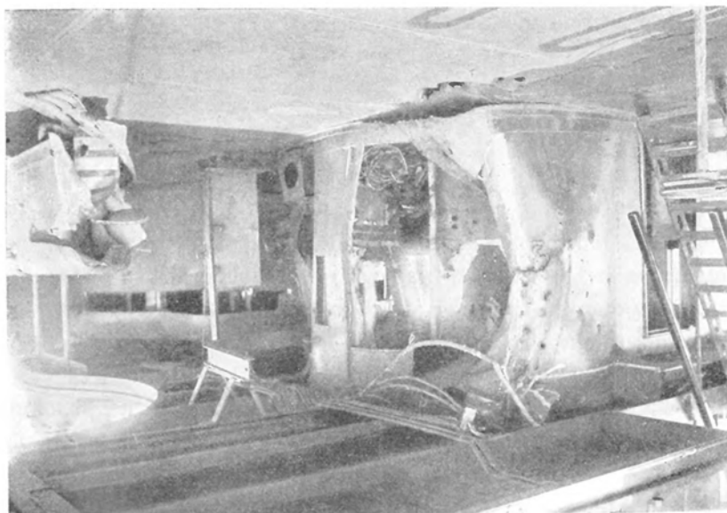
Разрушенія на „Цесаревичъ“.
