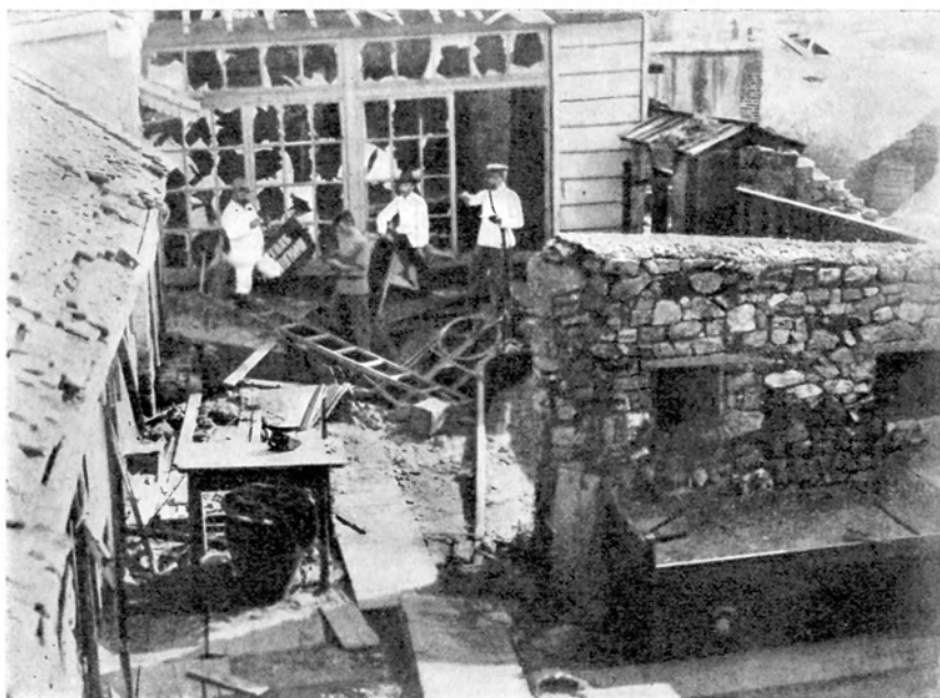
Разрушеніе отъ огня.
