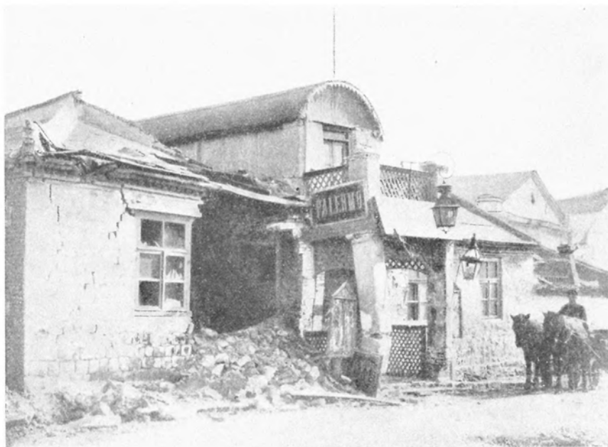
Разрушенія отъ бомбардировки.
