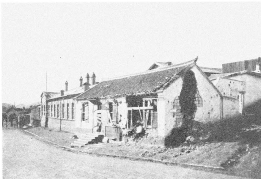
Разрушеніе отъ бомбардировки.
