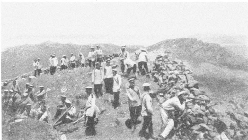
Постройка траншеи на Юпилазѣ.
