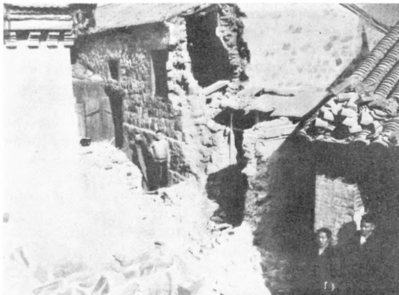
Разрушенные дома въ Портъ-Артурѣ.
