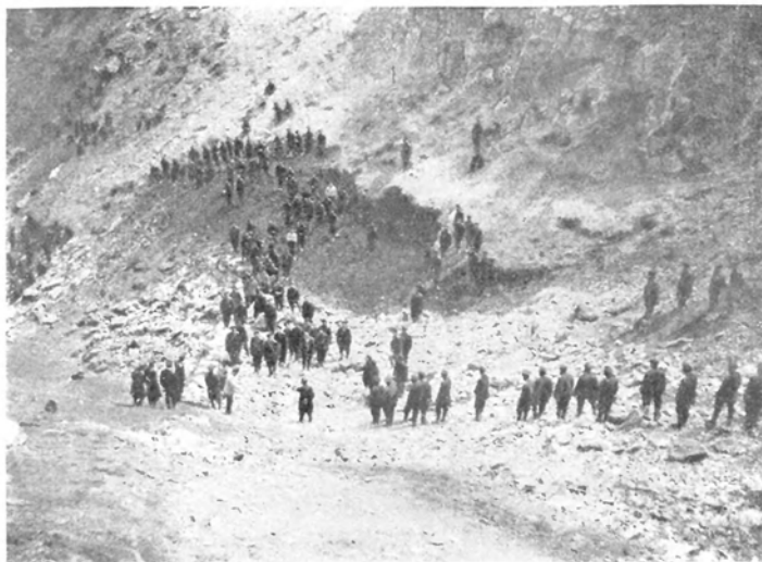
Работы по укрѣпленію Ляотешаня.
