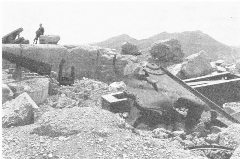
Разрушеніе на батарее.
