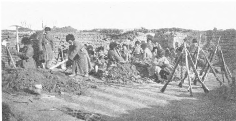
Работы по укрѣпленію.
